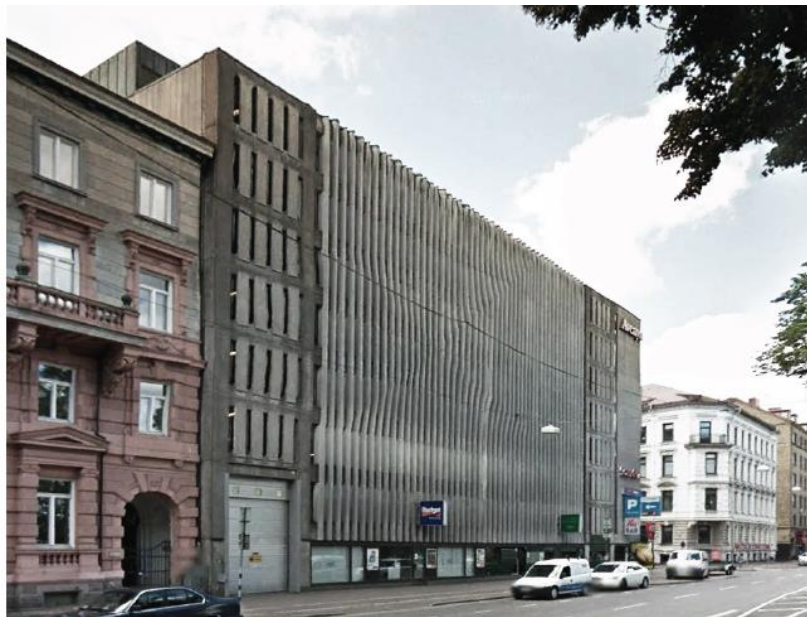
Figur 3. Foto över parkeringshuset där det går att se självdragsventilationen utformad som spalter i höjdlängd, längs fasaden som vetter mot Södra Vägen (Foto taget från underlaget erhållet från Erséus arkitekter/Balder).
